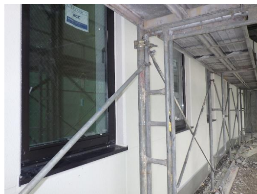
庁舎東側外壁塗装
