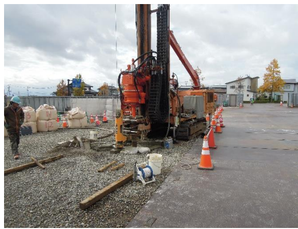
【地中熱ボーリング工事】
