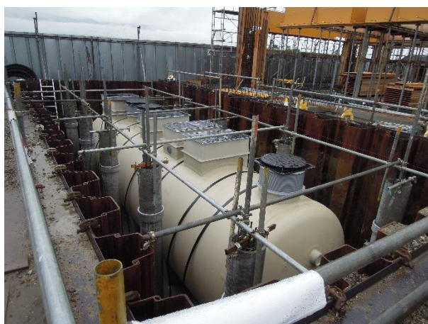
【浄化槽が設置されました】
