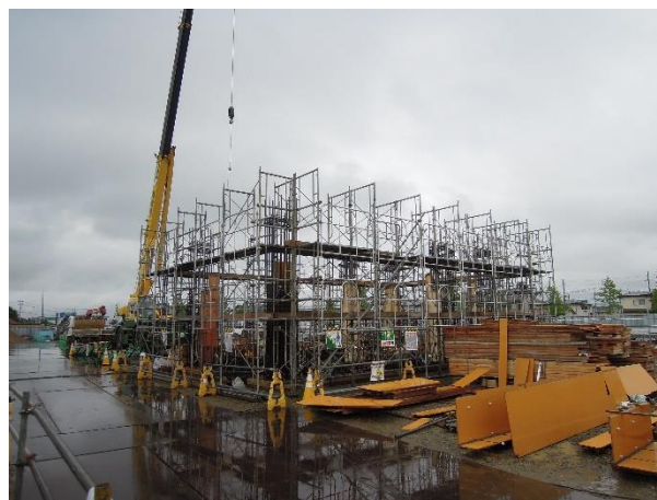
【訓練塔の躯体工事状況】
