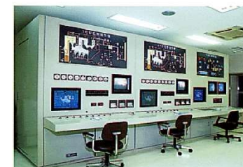
中央制御室 最新の自動制御技術を導入したワンルーム・コントロール方式です。燃焼管理はもちろん、各設備の監視運転操作を行います。
